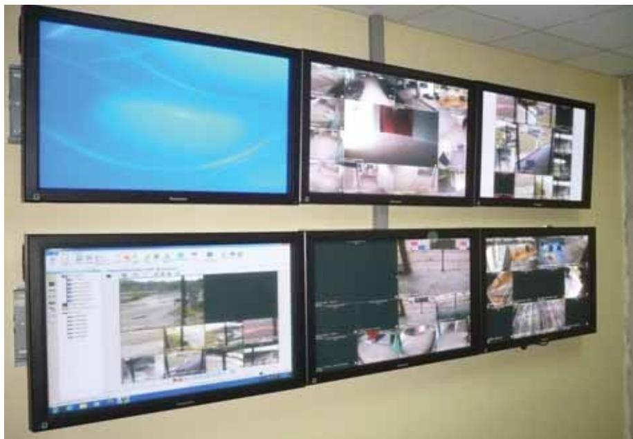
Instalado el sistema de seguridad integral, en el interior de cada estadio se montó una sala en la que se centralizó la recepción de imágenes e información captada por cada uno de los dispositivos.
